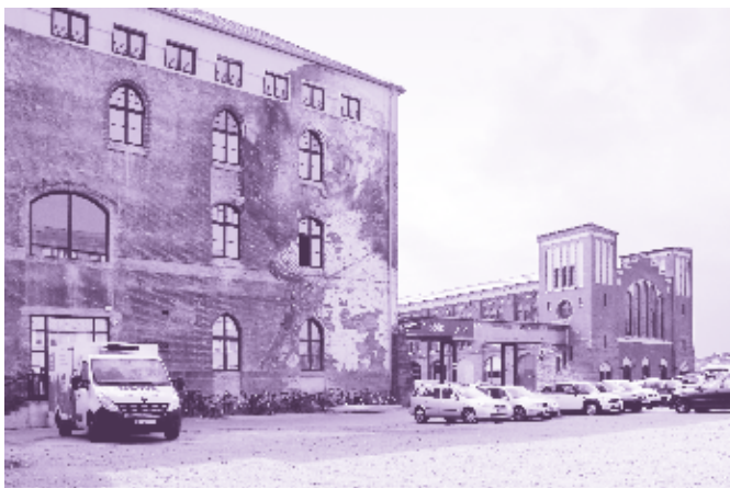
Straße der Pariser Kommune 8: Hier wird der Neubau der Stiftung entstehen.
